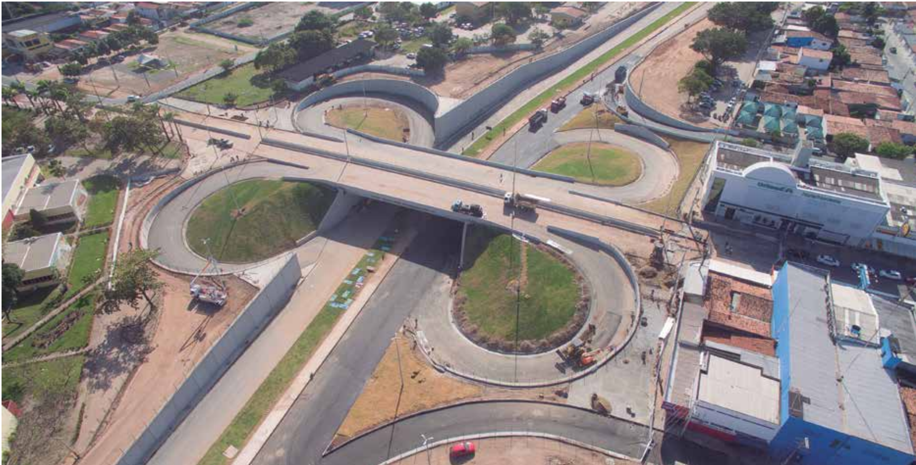
Trevo tem 800m 2 de extensão e contém um viaduto, quatro alças, duas pistas de rolamento, canteiro central, ciclovias e calçadas para pedestres
